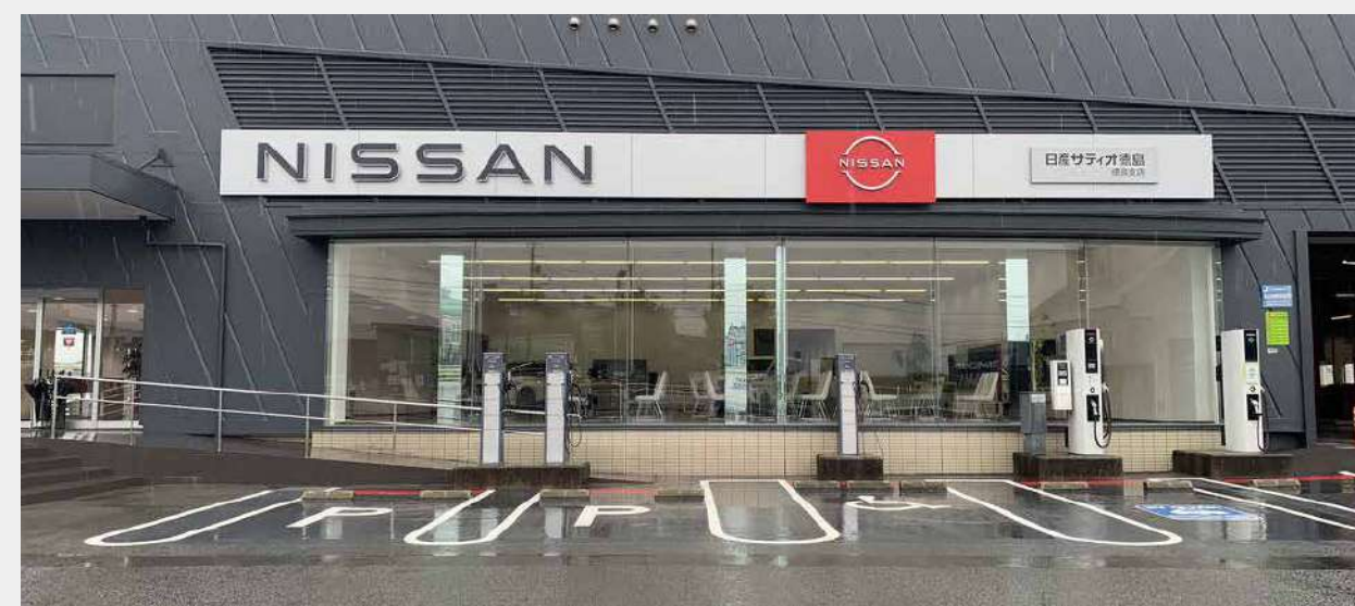
EV 車用の充電スタンド
