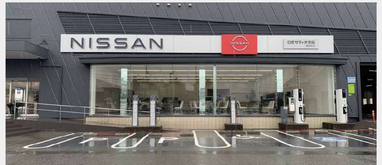
EV 車用の充電スタンド
